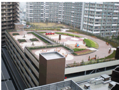
自走式立体駐車場屋上活用例
