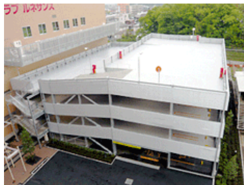
自走式立体駐車場屋上階例
